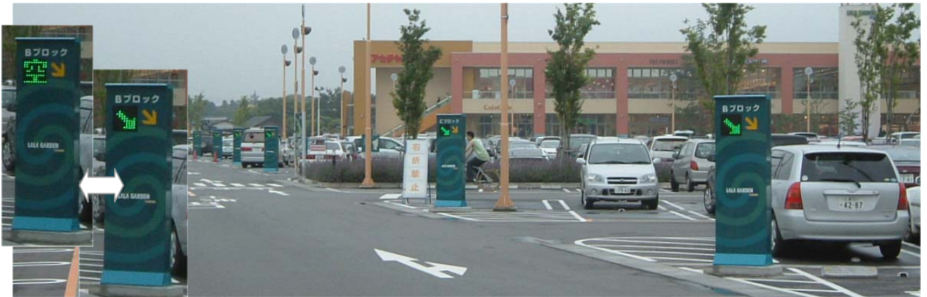
下写真) 一列に並んだ10枚の車路誘導板 満車ブロックは「満」、空車ブロックは「空」と「→」が同期して切り替え表示。 1秒おきに切り替わるので、極めて視認性が高い。
